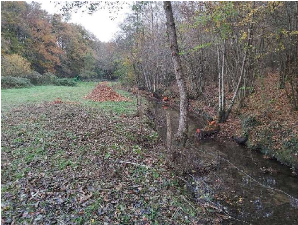
Travaux ripisylve en 2021
