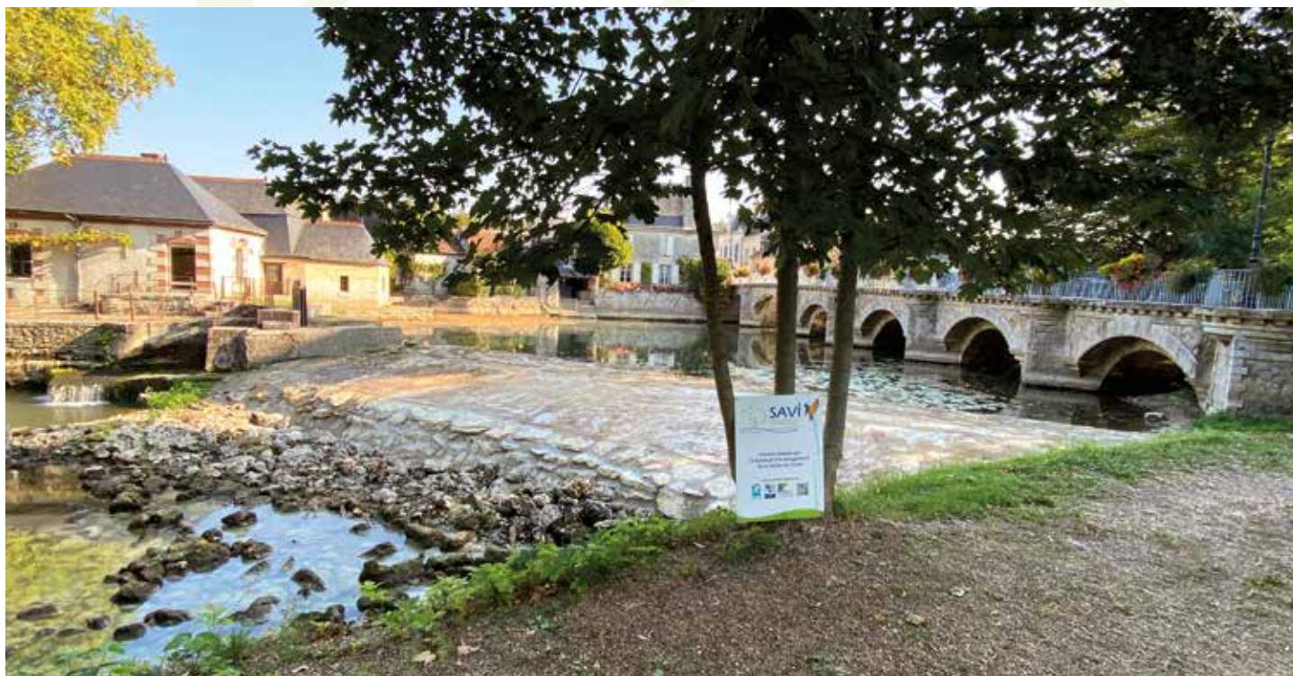
Travaux sur le déversoir du moulin d'Azay-le-Rideau – Septembre 2020
