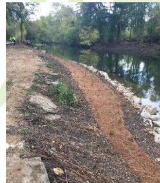
*Mise en place de la terre végétale, d'un toilage biodégradable*
