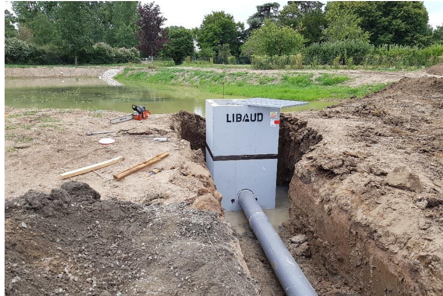
Système de vidange : pose d'un moine avec canalisation 300 mm
