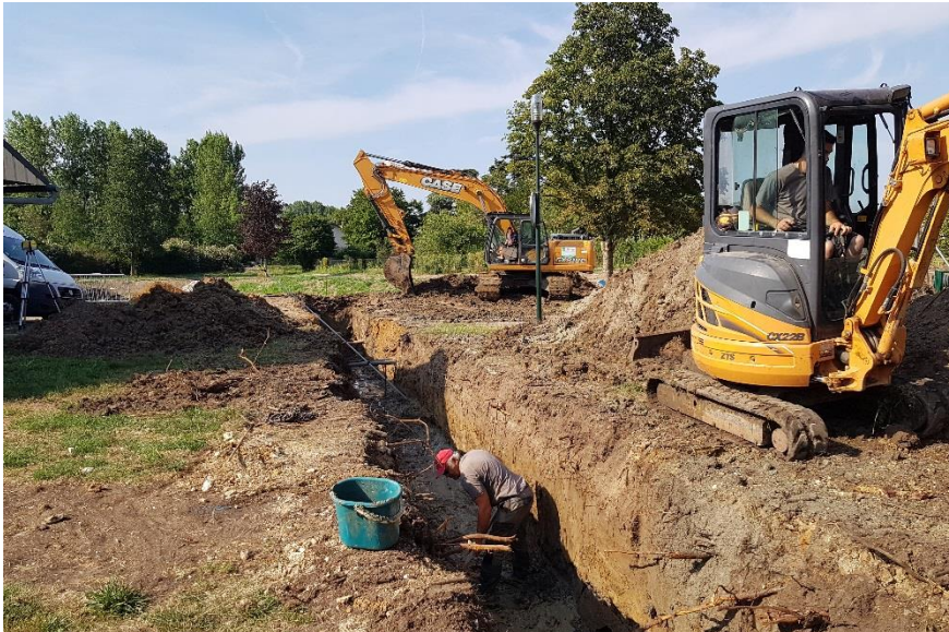
Système de vidange : pose d'un moine avec canalisation 300 mm
