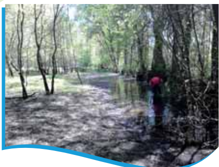
Ouverture et curage de bras
