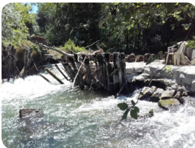
Le déversoir du Moulin de la Fresnaye
