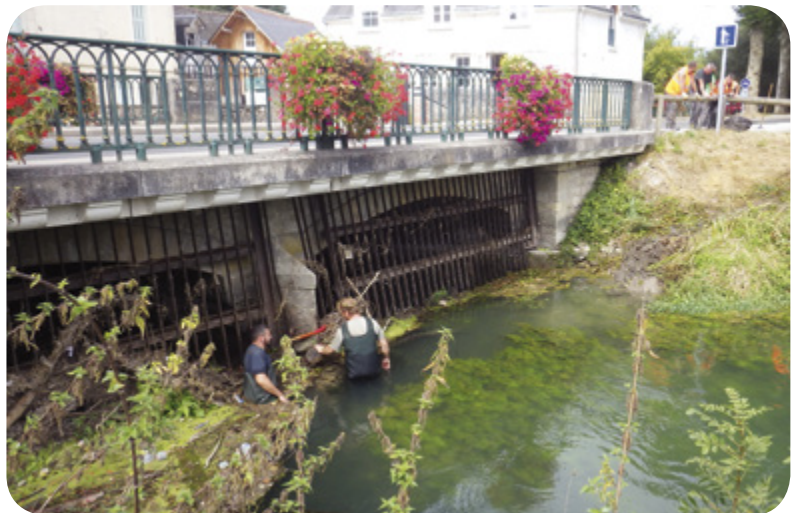
Entretien vannes moulinière - Moulin de Pont de Ruan Association Objectif - Septembre 2016
