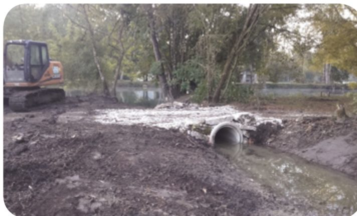
Remplacement ouvrage - Boire de la Roche à Monts - Octobre 2016
