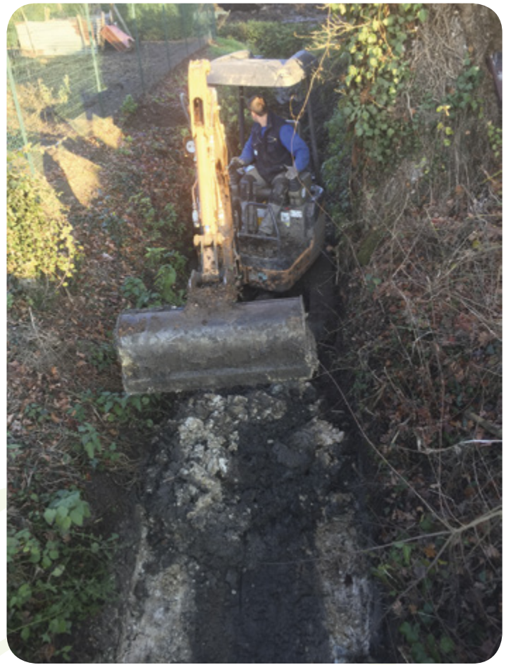
Fossé Grand rue à St Branchs
