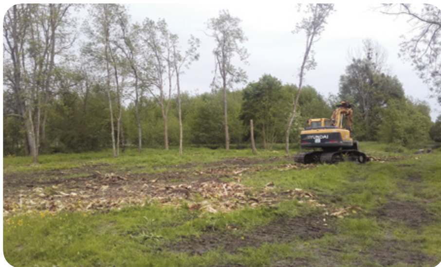
Dessouchage après abattage d'une parcelle communale à Monts
