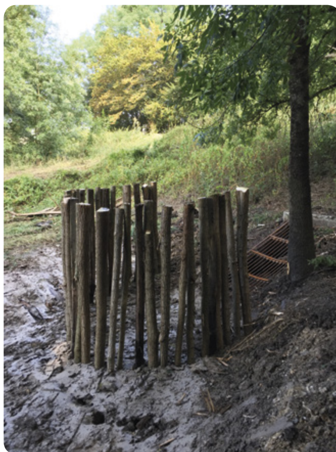
Création d'un filtre à encombres - Bassin de la Fleuriette - Montbazon
