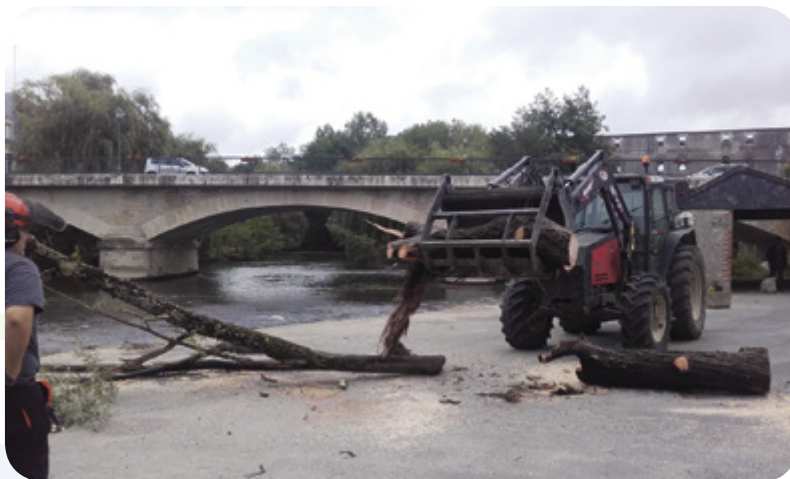
Encombre au Pont de Cormery - Environnement 41 - Septembre 2016
