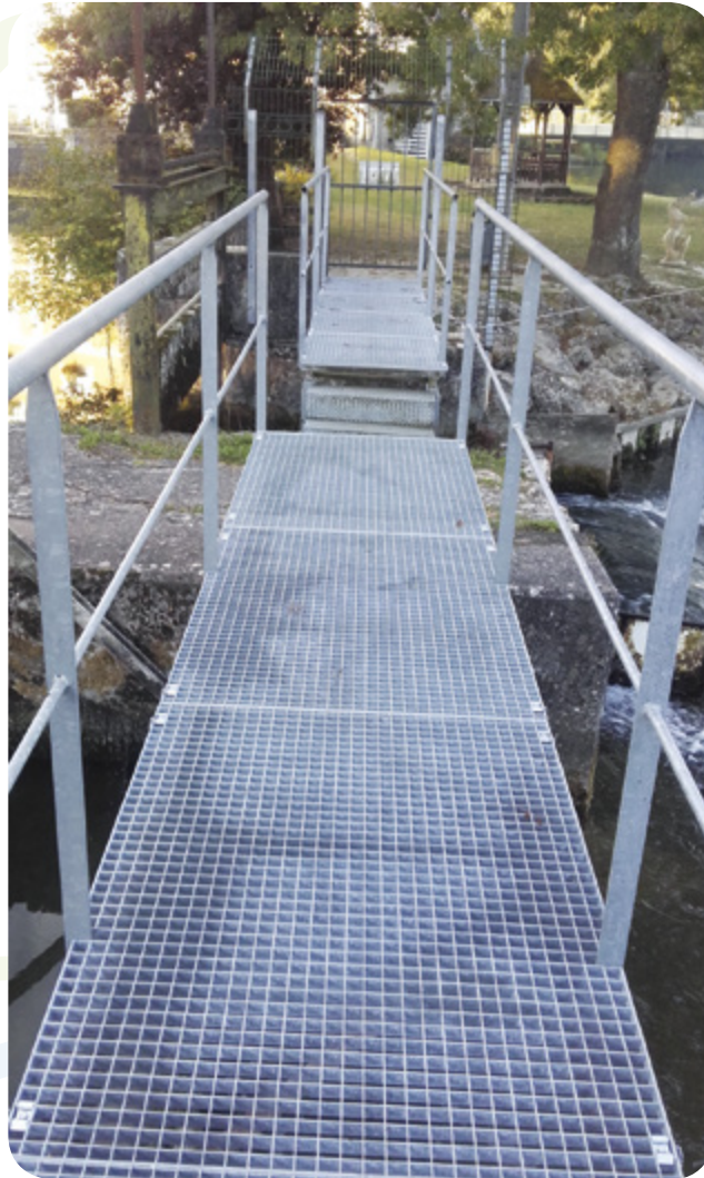
Remplacement de la Passerelle d'accès aux vannes du Moulin de Veigné
