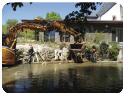
Création d'un radier et mise en place de protection de berges végétalisées à l'aval du moulin (juillet 2016)
