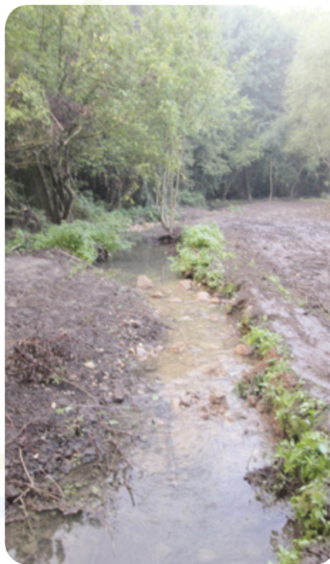
Restauration morphologique (suppression d'un étang, recharge, banquettes,...) Ruisseau du Jolivet à Villaines-les-Rochers - Septembre 2016
