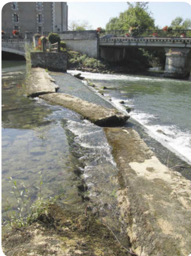
Le déversoir du Moulin d'Artannes sur Indre
