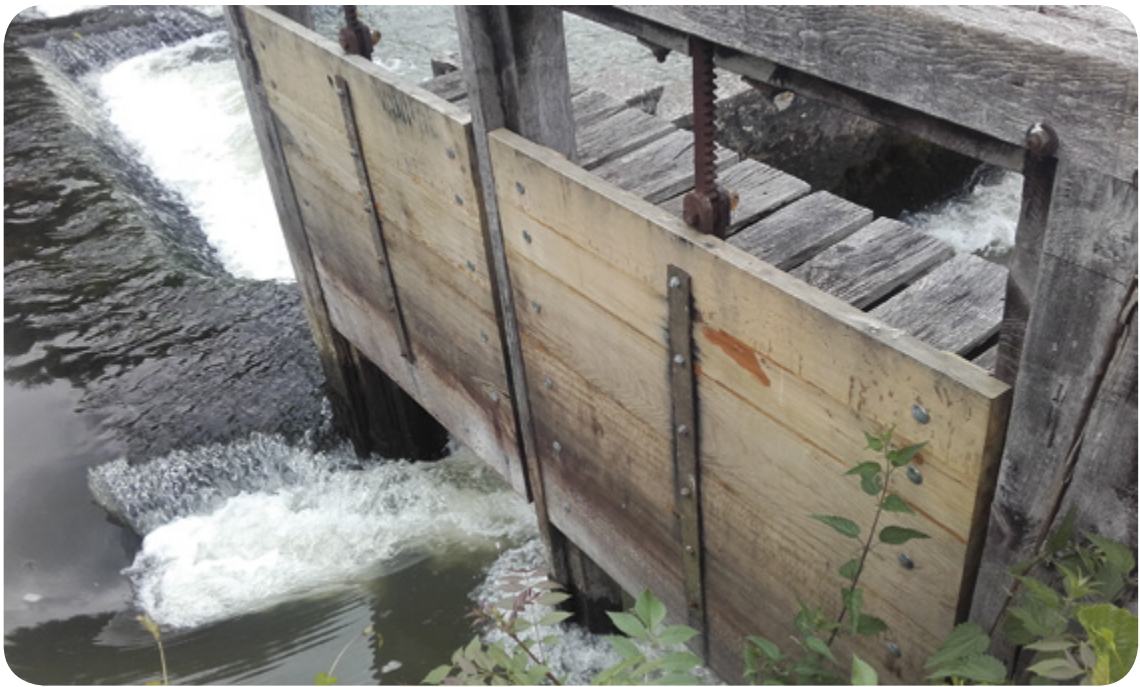
Réparation de la vanne de décharge du Moulin de Pont de Ruan - Entreprise CROIX - Juin 2016
