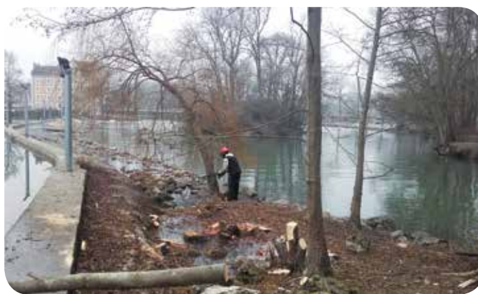
Entretien du déversoir du moulin de Veigné
