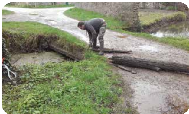
Nettoyage pont cadre - Cormery
