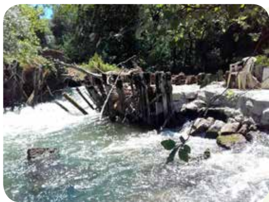
Déversoir du Moulin de la Fresnaye
