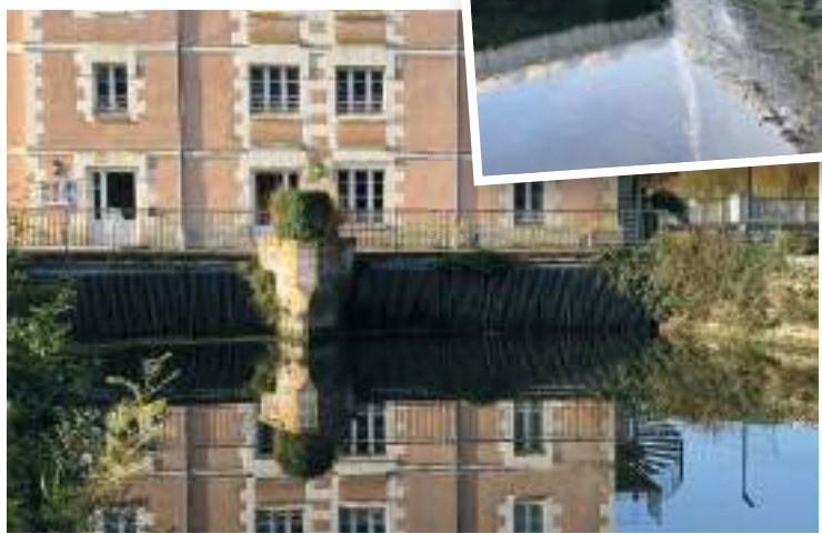
Moulin de Veigné après intervention
