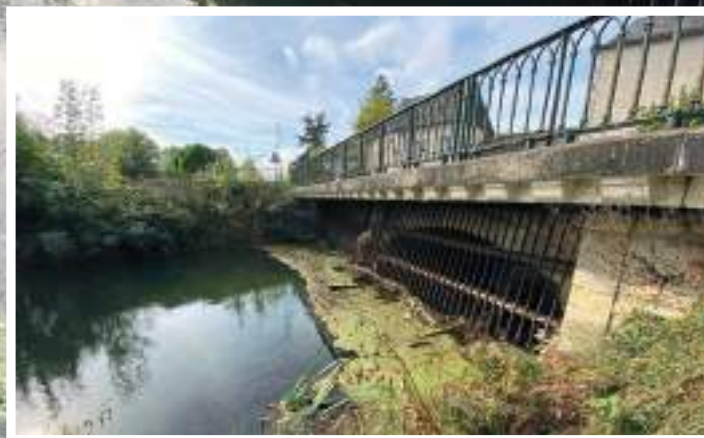
Grilles de Pont de Ruan avant intervention
