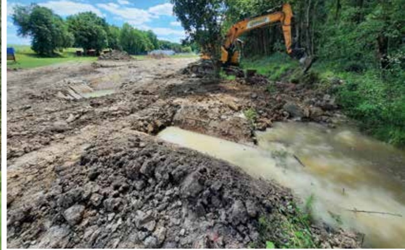
REBOUCHAGE DE L'ANCIEN LIT
