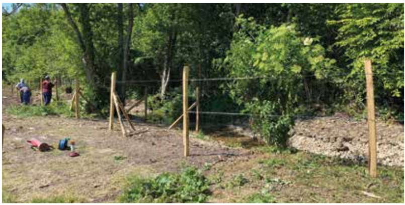
REPOSE DE CLÔTURES
