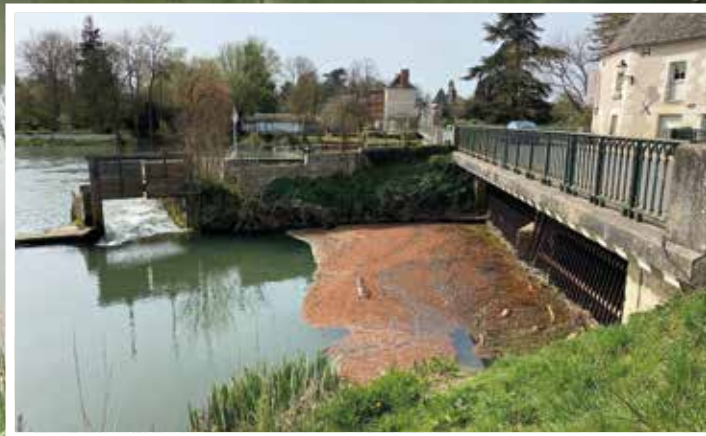
Grilles de Pont-de-Ruan avant intervention
