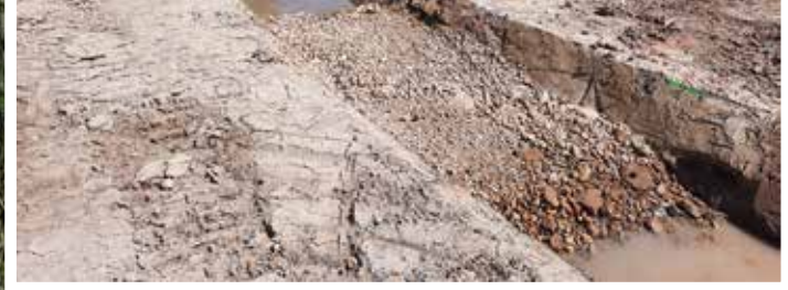
MISE EN PLACE DES RADIERS
